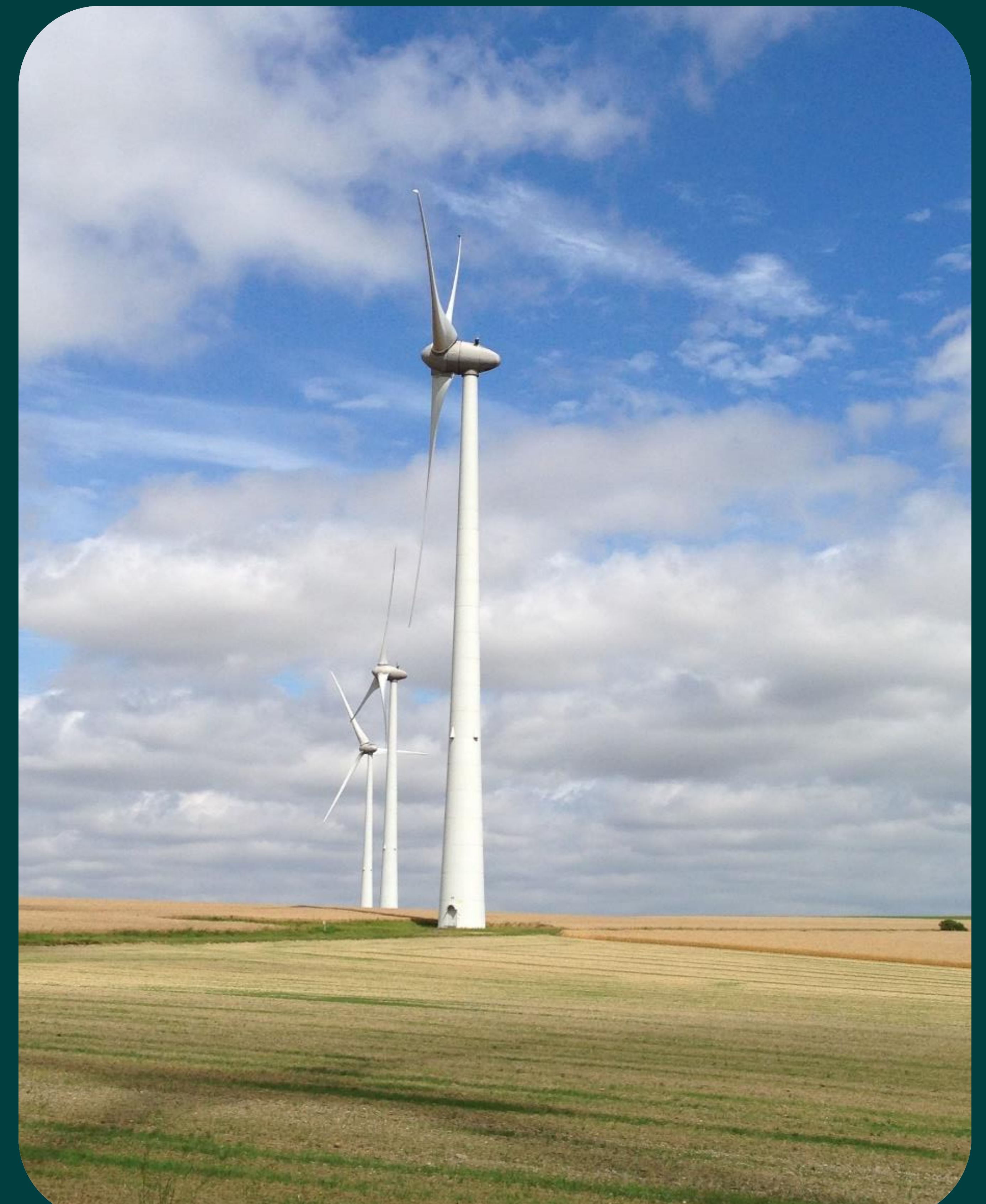
Parc éolien Innergex (France)
